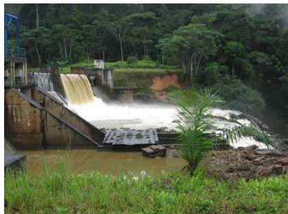
Barrage de Tchimbélé
